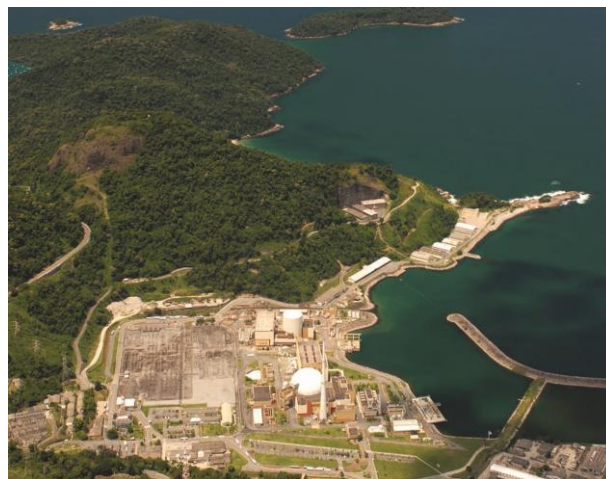
Figura 32: Praia de Itaorna em 2009. Fonte: ELETRONUCLEAR.
