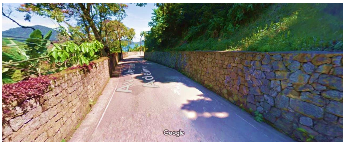
Figura 29: Muro na Estrada do Contorno. Fonte: Google Maps, street view. 2017.
