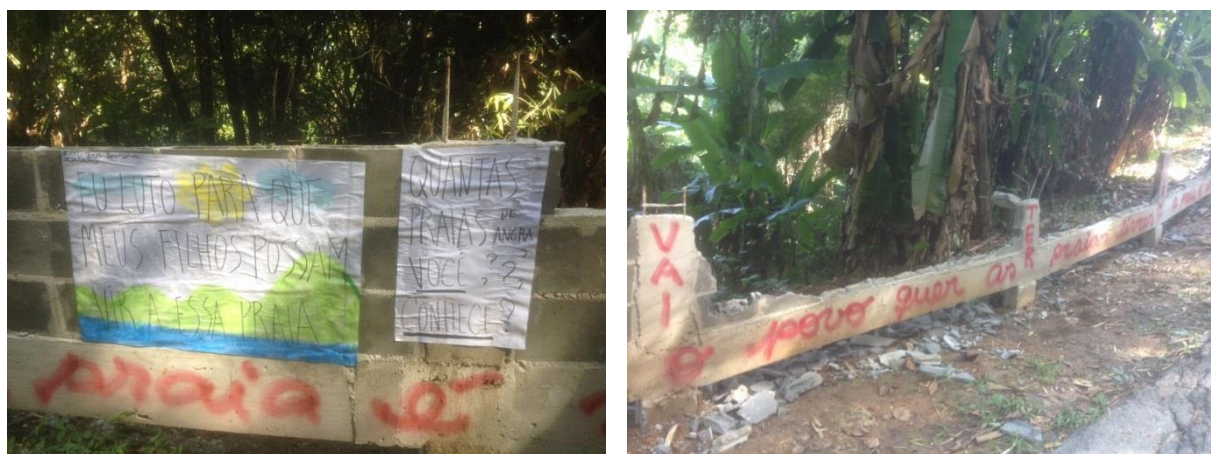
Figura 63: À esquerda: lambe-lambe no muro. À direita: muro quebrado.
