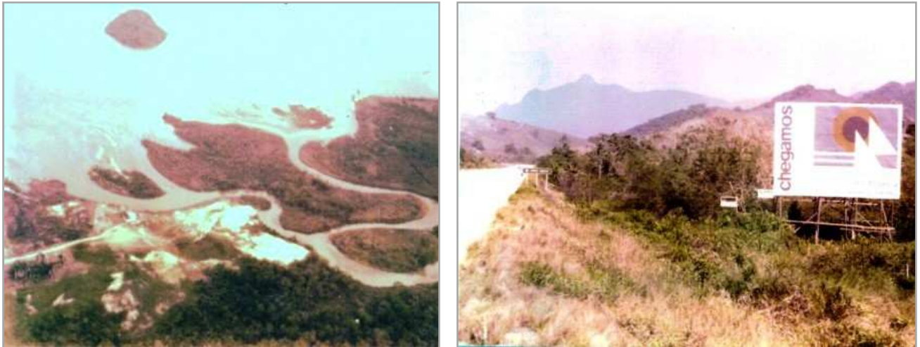
Figuras 29 e 30 – Construção do Porto Marina Bracuhy e placa indicativa na rodovia. s/d. Fonte: http://www.marinabracuhy.com.br/consbracuhy.htm . 2011.
