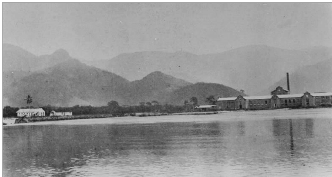
Figura 31 – Antigo Engenho Central do Bracuhy. Data provável 1922. Fonte: http://transparenciaangra.blogspot.com/2008/12/angra-antiga-na-internet.html . 2011.
