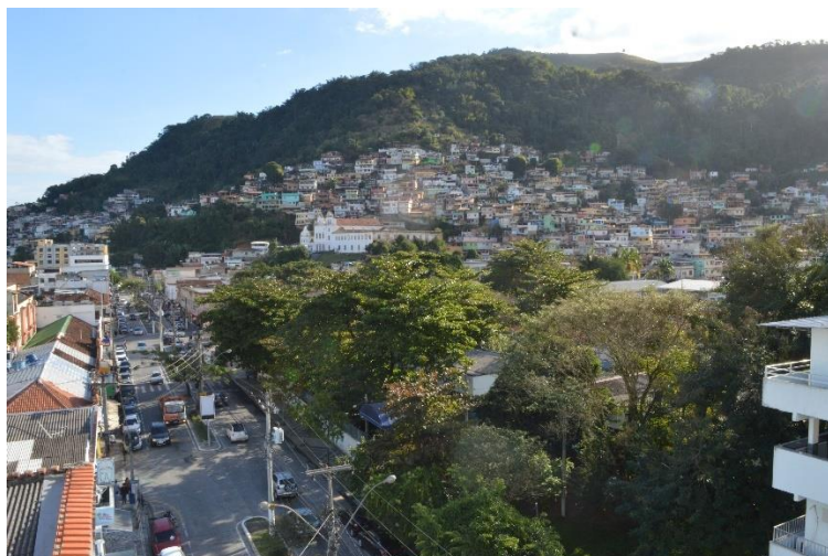
Figura 33: Entorno Convento São Bernardino de Sena atualmente Fonte: Arquivo pessoal / Autor: Nítalo Talarico, 2017
